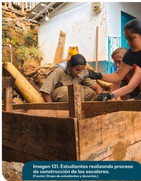
Imagen 131. Estudiantes realizando proceso de construcción de las escaleras.
