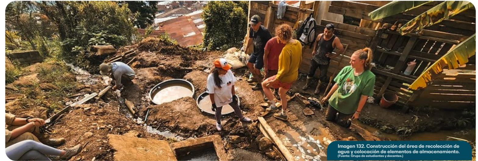
Imagen 132. Construcción del área de recolección de agua y colocación de elementos de almacenamiento.
