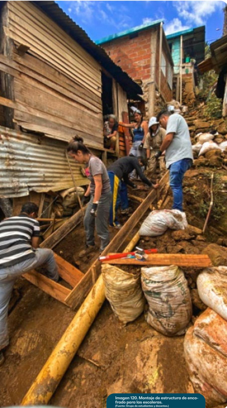
Imagen 120. Montaje de estructura de encofrado para las escaleras.
